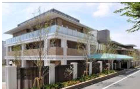
「アライブ世田谷中町」 外観
